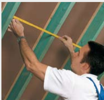
Fig. 1 Meet de ruimte tussen 2 kepers en voeg hier 1 à 2 cm aan toe.
