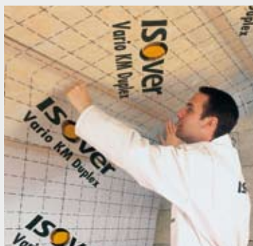
Fig. 4 Breng een lucht/dampscherm aan, zoals Isover vario KM duplex. Appeze un pare-vent/vapeur, comme l'Isover vario KM duplex.
